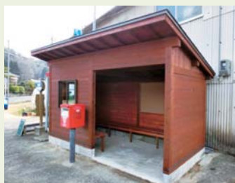
工作物 バス停建屋施工
