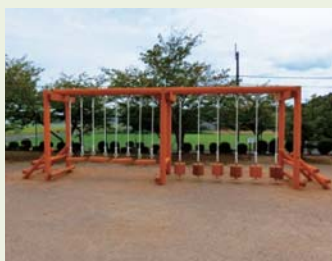
工作物 遊具設備施工
