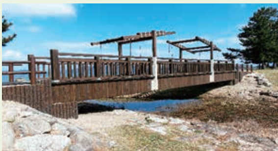
中主町 野々宮橋改修工事 工作物:跳ね橋施工
