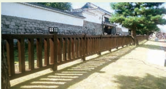
京都 二条城 工作物:木柵施工
