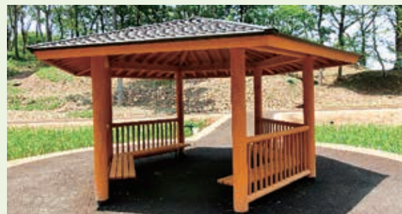
奈良 新沢千塚古墳群 工作物:四阿施工
