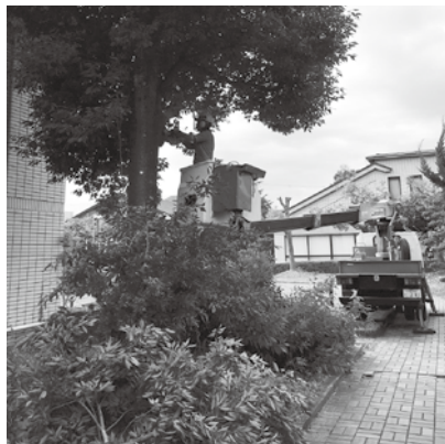
高所作業車を使用しての枝落とし
